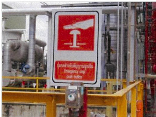
ภาพที่ 2.2-22 ปุ่มกดแจ้งเหตุสัญญาณฉุกเฉิน
