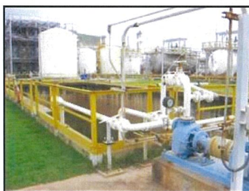
ภาพที่ 2.2-21 ลานถัง และบ่อรองรับสารเคมีหากเกิดการรั่วไหล
