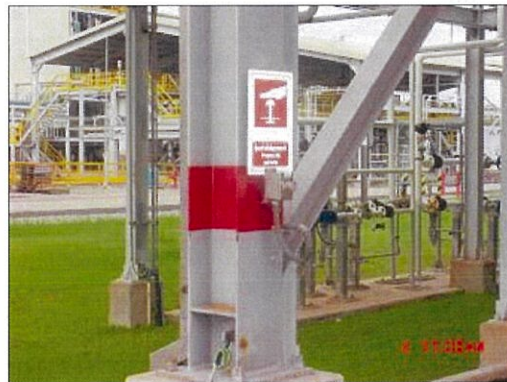
ภาพที่ 2.2-22 ปุ่มกดแจ้งเหตุสัญญาณฉุกเฉิน
