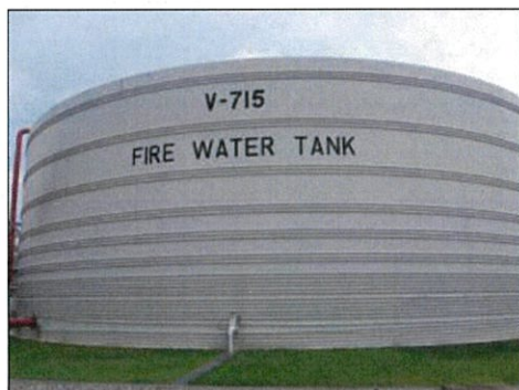
ถังน้ำดับเพลิงขนาด 12,000 ลูกบาศก์เมตร
