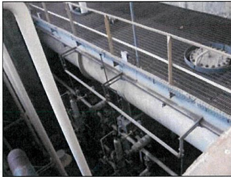
ภาพที่ 2.2-10 ถังแยกไฮโดรคาร์บอนที่ปนเปื้อนในน้ำ (AD-498)
