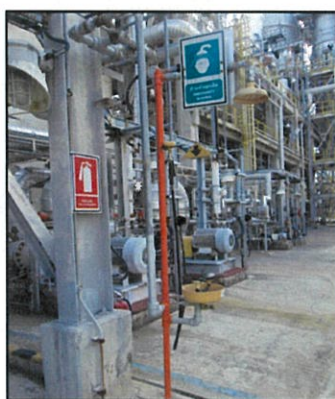
ภาพที่ 2.2-17 ฝักบัวและที่ล้างตาฉุกเฉิน
