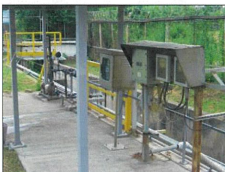
ภาพที่ 2.2-8 Continuous Analyzer บริเวณ Outfall Pit
