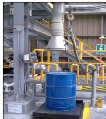
พัฒนาระบายอากาศบริเวณสูบน้ำถ่ายสารเคมีจากถัง
