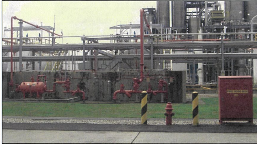
ระบบไพม์ดับเพลิง และสายดับเพลิง บริเวณถังเก็บวัตถุดิบ
