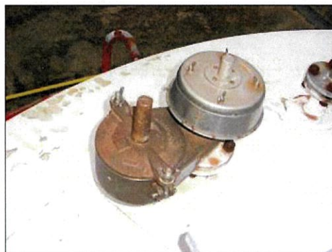
วาล์วระบายความดันและป้องกันการเกิดสุญญากาศ (Pressure-Vacuum Relief Valve) สำหรับถังเก็บสารเคมี
