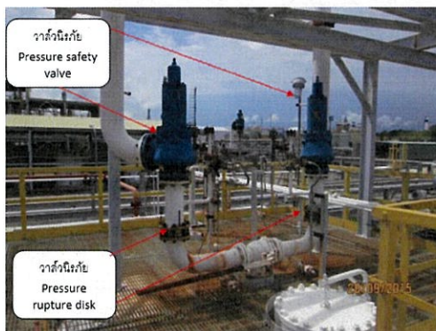
วาล์วนิรภัย และอุปกรณ์ระบายความดัน (Rupture Disc) ป้องกันระบบถังปฏิกรณ์
