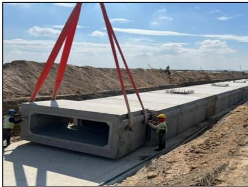
งาน Precast Boxculvert
