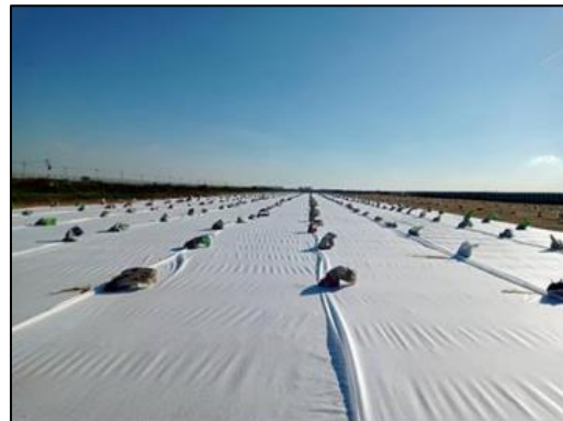
งานติดตั้ง Geotextile-Extension D-1
