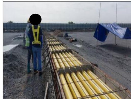
งาน Pit and Duct Bank-South Area
