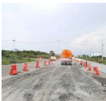
งานปรับปรุงถนนบริเวณทางเข้า-ออก พื้นที่ก่อสร้าง (Construction gate)
