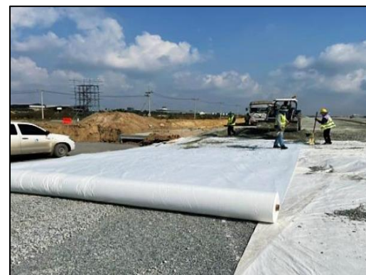
งาน Geotextile for Earthwork-South
