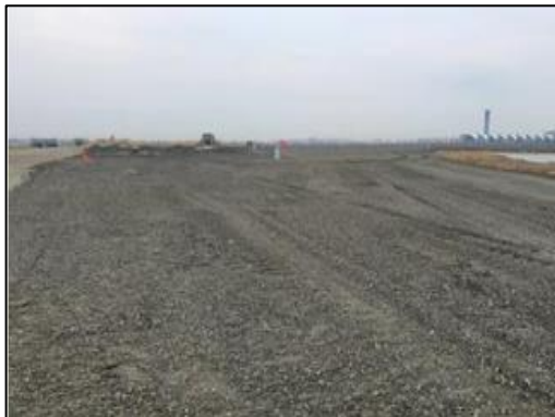
งานถม Crushed Rock – Perimeter Taxiway
