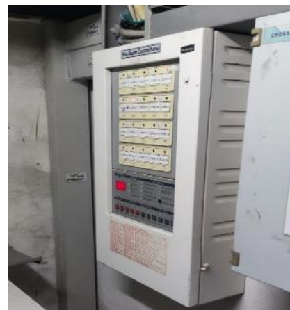
รูปที่ 2-34 แผงควบคุม (Fire Alarm Control Panel :FCP)
