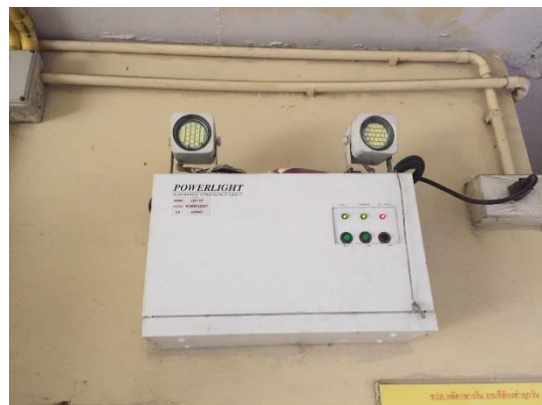
รูปที่ 2-29 ระบบไฟฟ้าส่องสว่างฉุกเฉิน
