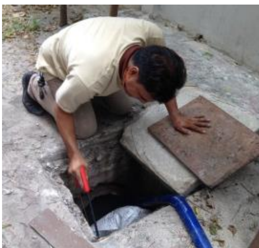
รูปที่ 2-48 การทำความสะอาดของท่อระบายน้ำ
