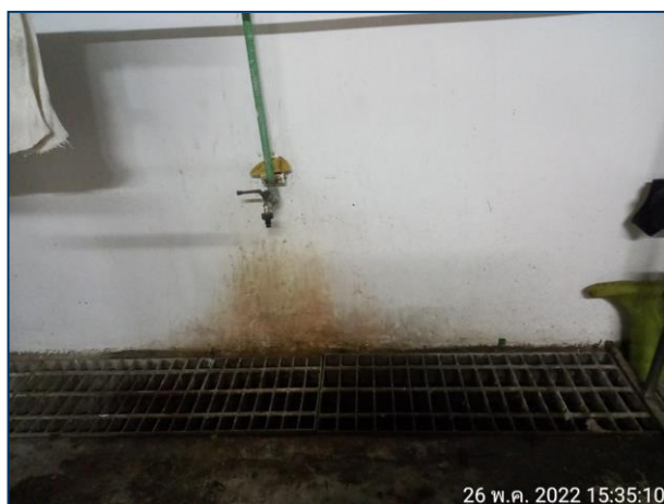
รูปที่ 2.16 ท่อระบายน้ำเสียหายจากการล้างห้องพักขยะ
