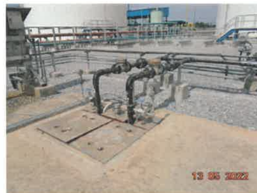
ภาพที่ 2.2-12 บ่อตรวจสอบคุณภาพน้ำทิ้ง พร้อมวาล์ว ของโรงไฟฟ้า
