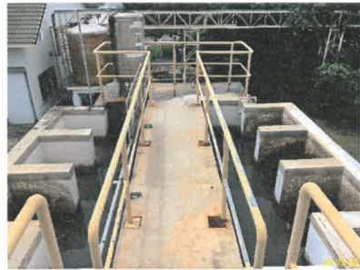
ระบบสร้างตะกอน
