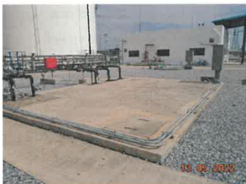
ภาพที่ 2.2-12 บ่อตรวจสอบคุณภาพน้ำทิ้ง พร้อมวาล์ว ของโรงไฟฟ้า
