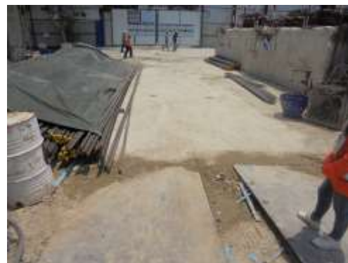
รูปที่ 18 ผ้าใบปิดคลุมวัสดุก่อสร้าง
