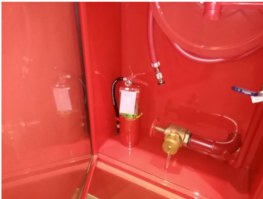
ภาพที่ 20 แสดงตู้เก็บสายน้ำดับเพลิง-ถังดับเพลิง
