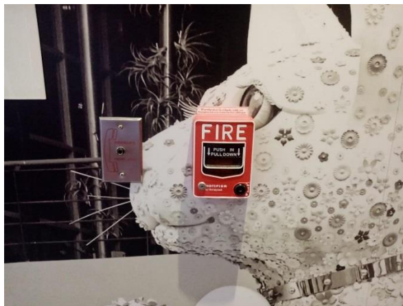
ภาพที่ 19 แสดงอุปกรณ์แจ้งเหตุเพลิงไหม้ (Fire Alarm bell)
