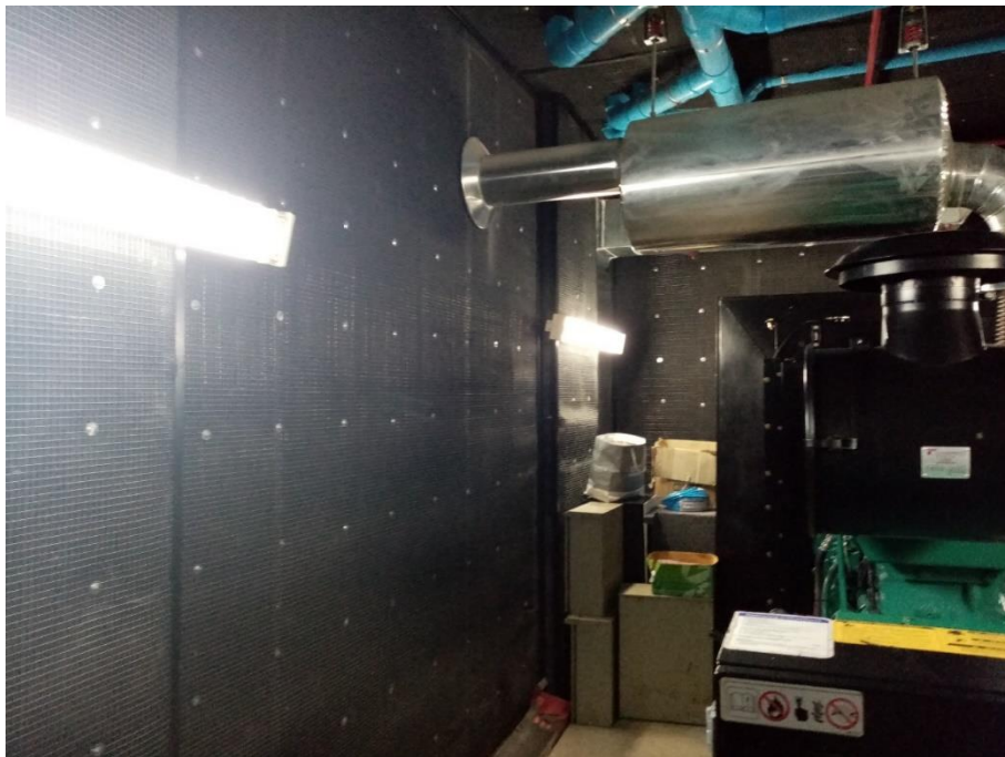
ภาพที่ 40 แสดงอุปกรณ์รับเสียงของห้องเครื่องปั่นไฟ
