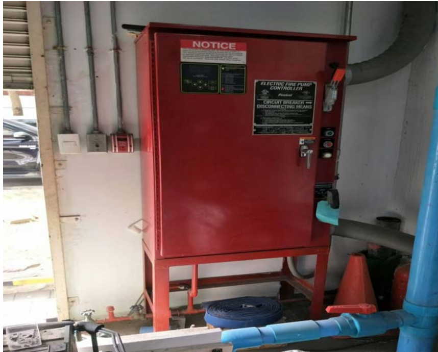
ภาพที่ 9 แสดงตู้ควบคุมระบบดับเพลิง ภายในโครงการ
