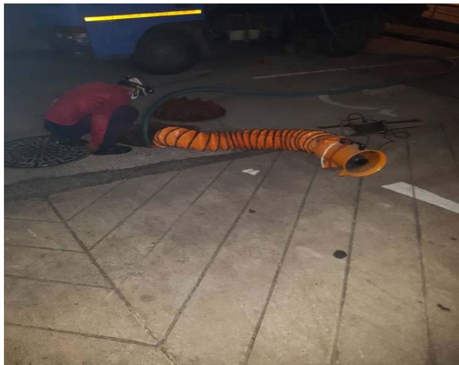
ภาพที่ 34 เจ้าหน้าที่ทำการสูบตะกอนจากถังบำบัดน้ำเสียขึ้นตัน( Septic Tank)
