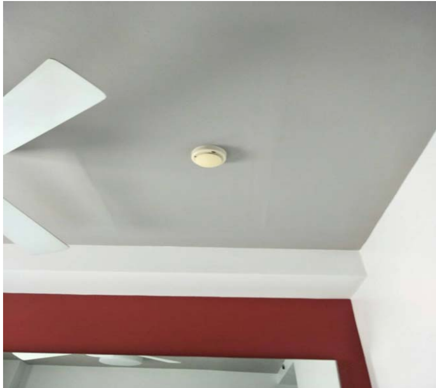
ภาพที่ 11 แสดง เครื่องตรวจจับความร้อน ภายในห้องพักของโครงการ
