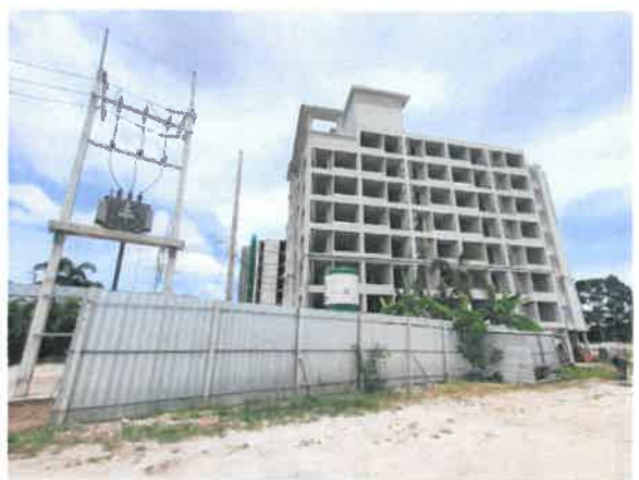
รูปที่ 2-1 แสดงรั้ว Metal Sheet ความสูง 6 เมตร โดยรอบพื้นที่ก่อสร้าง
