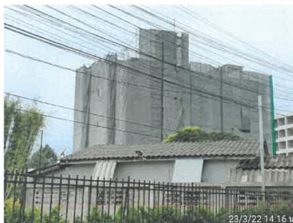
รูปที่ 2-8 แสดงติดตั้ง Mesh Sheet คลุมอาคาร B
