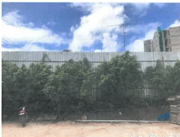
รูปที่ 2-1 แสดงรั้ว Metal Sheet ความสูง 6 เมตร โดยรอบพื้นที่ก่อสร้าง
