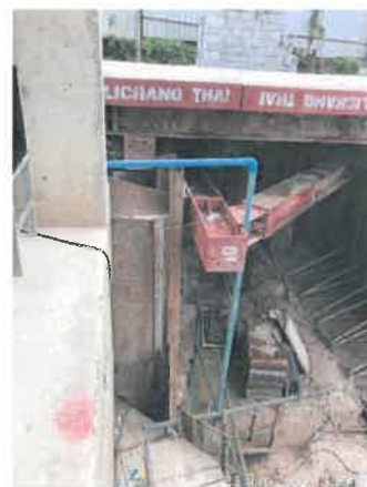
รูปที่ 2-27 แสดงติดตั้งท่อระบายน้ำ สำหรับรวบรวมน้ำเข้าสู่บ่อพัก
