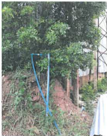
รูปที่ 2-27 แสดงติดตั้งท่อระบายน้ำ สำหรับรวบรวมน้ำเข้าสู่บ่อพัก
