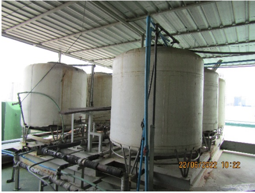
ถังเก็บน้ำร้อนบนชั้นดาดฟ้า
