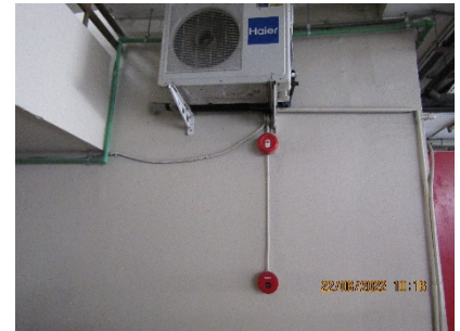
alarm bell และ fire alarm manual station
