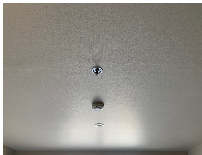
smoke detector และ sprinkle fire
