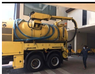
การสูบน้ำจากระบบบำบัดน้ำเสีย
