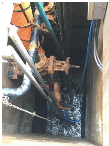
ภาพที่ 2.2-8 การสูบน้ำและตัดไขมัน
