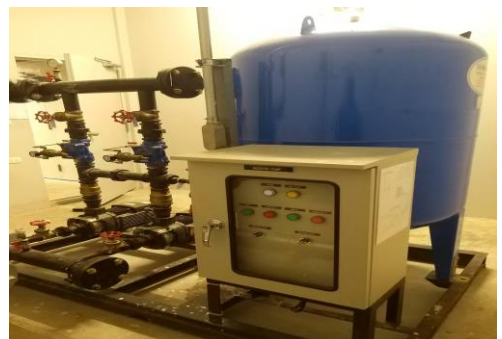
ปั๊ม และถังเก็บน้ำสำรองเพื่อการอุปโภค-บริโภค และเพื่อการดับเพลิงชั้นใต้ดิน
