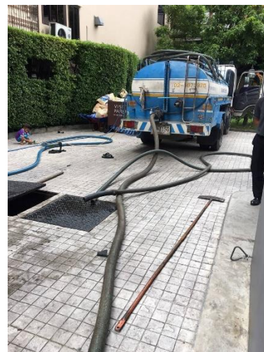
ภาพที่ 2.2-8 การสูบน้ำและตัดไขมัน
