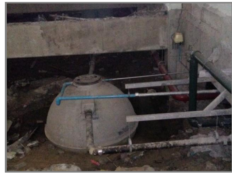
ภาพที่ 2.2-10 ระบบบำบัดน้ำเสียศูนย์ซ่อมบำรุง
