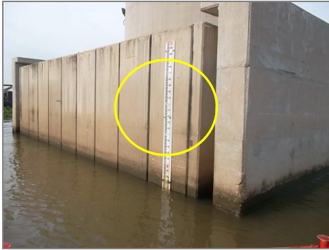
ภาพที่ 2.2-18 บรรทัดน้ำบริเวณต่อม่อสะพานรถไฟฟ้
