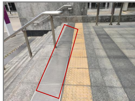
ภาพที่ 2.2-23 ระบบระบายน้ำบริเวณสถานีรถไฟฟ้า
