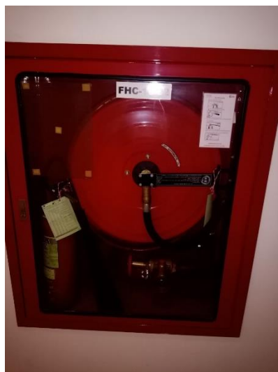
ภาพที่ 28 แสดงตู้เก็บสายฉีดสายดับเพลิงพร้อมอุปกรณ์
