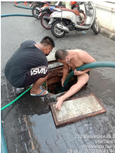
ภาพที่ 15 แสดงการดูตะกอนจากบ่อน้ำเสีย
