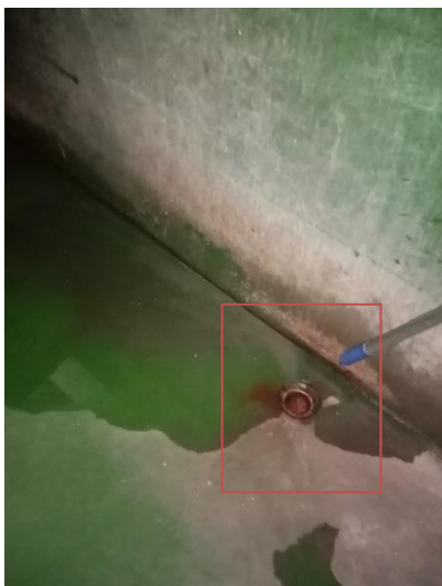
ภาพที่ 25 แสดงร่องรอยน้ำเสียจากห้องพักขยะ
