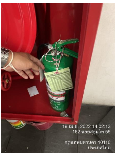
ภาพที่ 29 แสดงถังดับเพลิงชนิด ABC ติดตั้งในตู้ FHC
