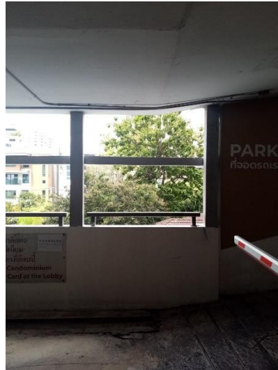
ภาพที่ 14 แสดงช่องระบายอากาศแบบธรรมชาติ
