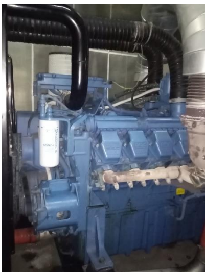
ภาพที่ 27 แสดงเครื่องกำเนิดไฟฟ้าฉุกเฉินของ โครงการ
