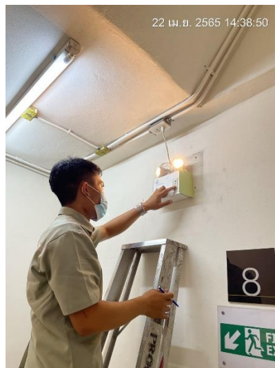
ภาพที่ 48 แสดงตรวจเช็คระบบไฟฉุกเฉิน
