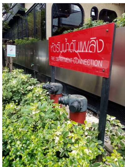
ภาพที่ 30 แสดงหัวรับน้ำดับเพลิงจากภายนอก
