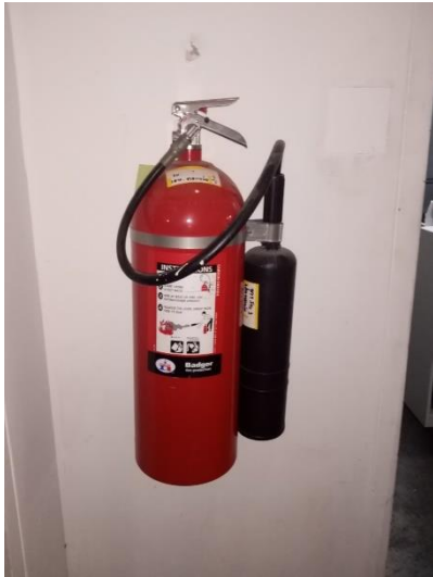
ภาพที่ 31 แสดงถังดับเพลิง CO 2 ภายในห้องต่างๆ
