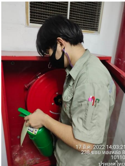
ภาพที่ 39 แสดงการตรวจสอบระบบป้องกันอัคคีภัย
