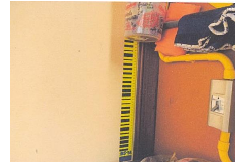
หมุดวัดการทรุดตัวของอาคาร BS33
