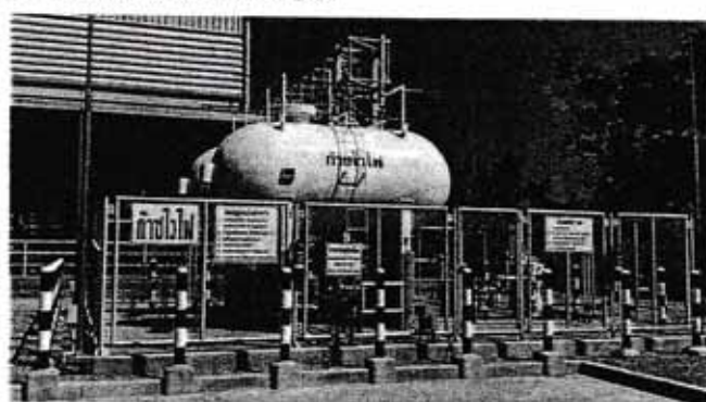
ภาชนะจัดเก็บ-จ่ายก๊าซ LPG ด้านหลังโรงงานที่ 4
