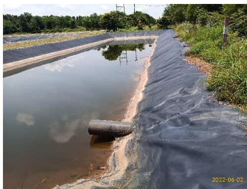
บ่อตรวจตรวจสอบสภาพน้ำ (Inspection Pond)
