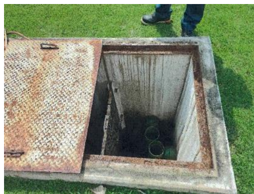
ภาพที่ 2.2-2 บ่อพักน้ำทิ้งหลังการบำบัดขนาด 1 วัน
