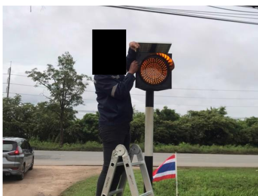
ภาพที่ 2.2-8 การซ่อมแซมสัญลักษณ์จราจร
