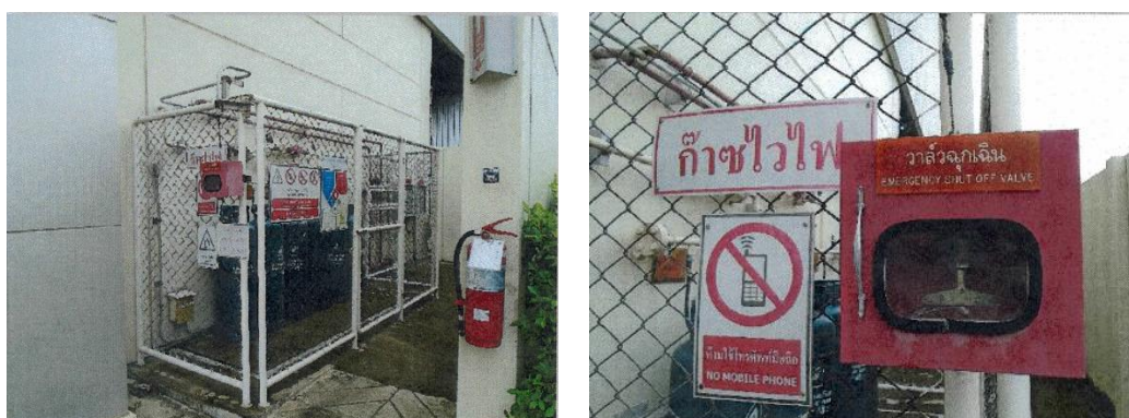
ภาพที่ 2.2-23 ตัวอย่างอุปกรณ์ป้องกันเหตุเพลิงไหม้สำหรับการเก็บก๊าซ LPG
