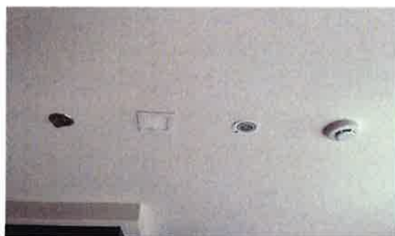
รูปที่ 2-9 สปริงเกอร์ และไฟฉุกเฉิน
