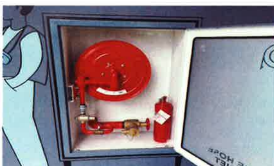
รูปที่ 2-13 ตู้เก็บอุปกรณ์ดับเพลิง
