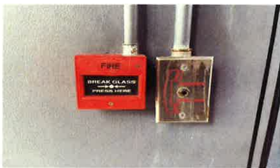
รูปที่ 2-8 อุปกรณ์แจ้งเหตุด้วยมือ และชุดเต้าเสียบโทรศัพท์
