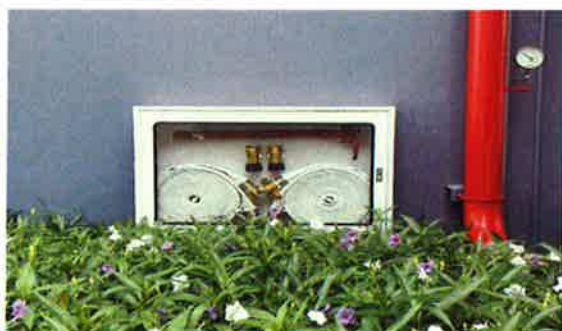
รูปที่ 2-6 หัวจ่ายน้ำดับเพลิงและสายส่งน้ำ
