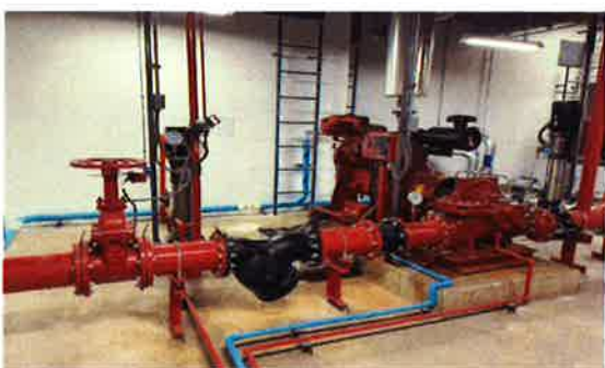
รูปที่ 2-12 ปั๊มน้ำดับเพลิง
