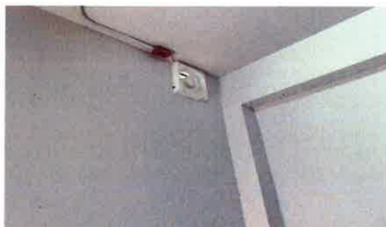
รูปที่ 2-19 พัดลมระบายอากาศในห้องพักขยะ
