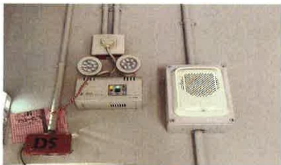
รูปที่ 2-14 เครื่องสำรวจไฟฟ้า และลำโพงแจ้งเหตุ
