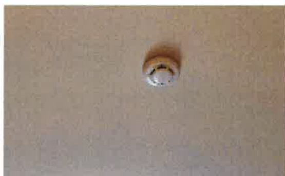
รูปที่ 2-11 เครื่องดับจับควัน
