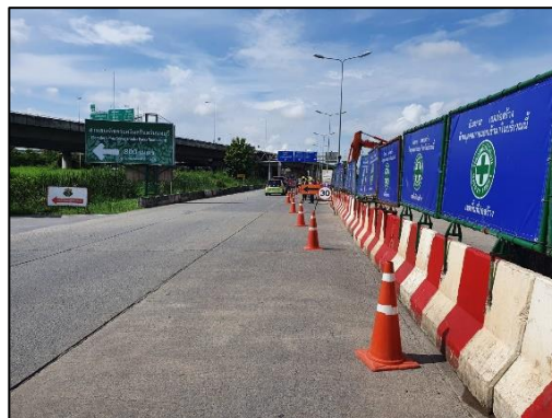
รูปที่ 2-21 การตีช่องจราจร และการจัดระยะสอบ
