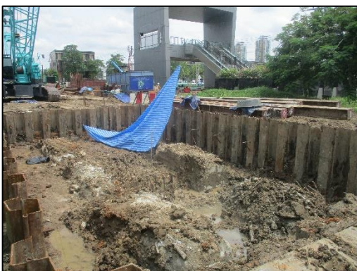
รูปที่ 2-3 การตอกเข็มพืด (Steel Sheet Pile)
