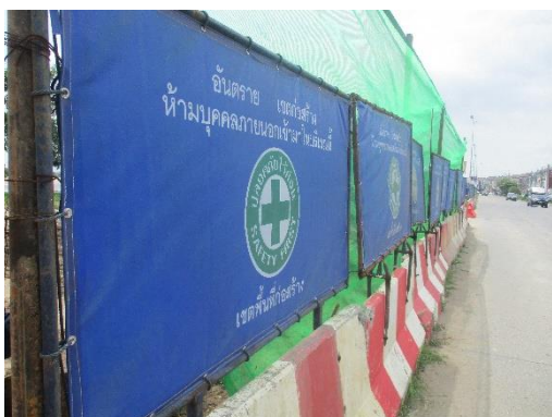
รูปที่ 2-1 การกั้นกำแพงคอนกรีต พร้อมรั้วผ้าใบทึบ ความสูง 2.0 เมตร
