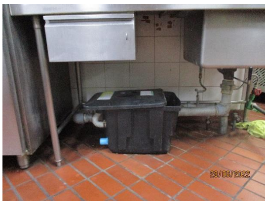
รูปที่ 2-21 ถังดักไขมันภายในห้องครัว
