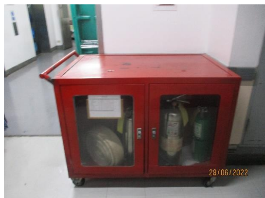
รูปที่ 2-35 ตู้เก็บอุปกรณ์ดับเพลิงเคลื่อนที่
