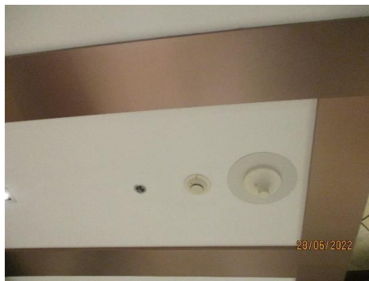
รูปที่ 2-44 อุปกรณ์ตรวจจับควันไฟ
