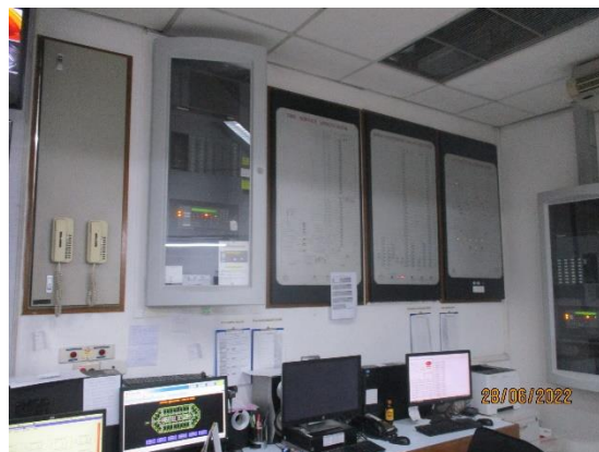
รูปที่ 2-38 แผงวงจรอิเล็กทรอนิกส์ เตือนอัคคีภัย ภายในห้องควบคุม และฝ้าระวางอัคคีภัยของโรงแรม
