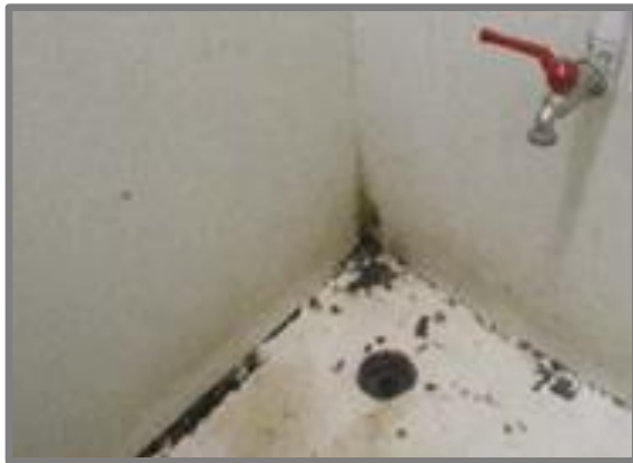
รูปที่ 2-14 ท่อรวบรวมน้ำเสียจากห้องพักมูลฝอย
