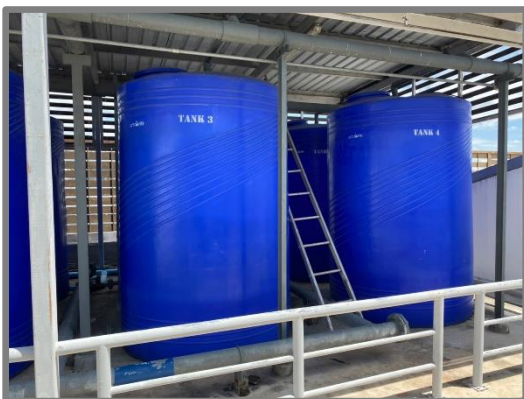
รูปที่ 2-7 ถังสำรองน้ำใช้ดับฟ้าและถังสำรองน้ำใต้ดิน
