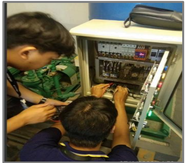
รูปที่ 2-41 การตรวจสอบระบบไฟ
