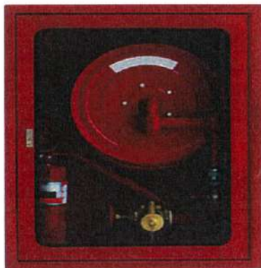
ภาพหัวจ่ายน้ำดับเพลิง อุปกรณ์ดับเพลิง และตู้ดับเพลิง
