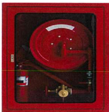
ภาพหน้าจ่ายน้ำดับเพลิง อุปกรณ์ดับเพลิง และตู้ดับเพลิง
