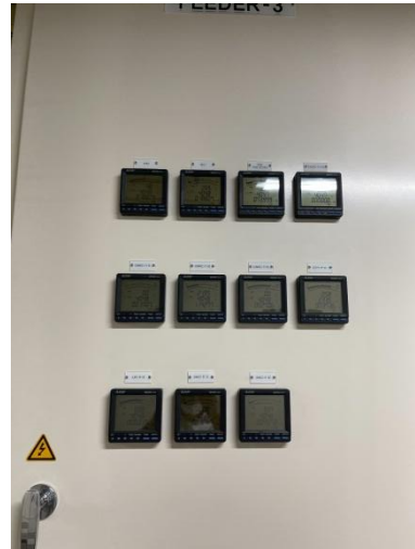
รูปที่ 2-13 ติดตั้งมิเตอร์ไฟฟ้าสำหรับระบบบำบัดน้ำเสีย
