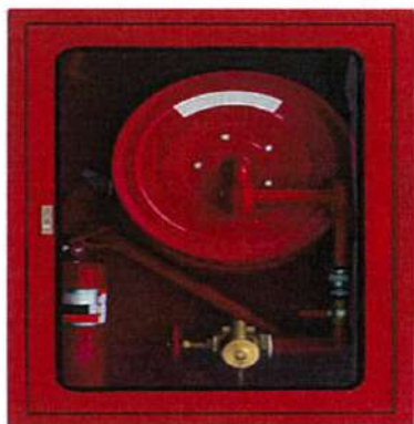
ภาพหน้าจ่ายน้ำดับเพลิง อุปกรณ์ดับเพลิง และตู้ดับเพลิง
