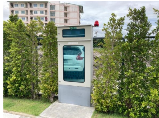
รูปที่ 2-11 ตัวควบคุมการทำงานของระบบบำบัดน้ำเสีย
