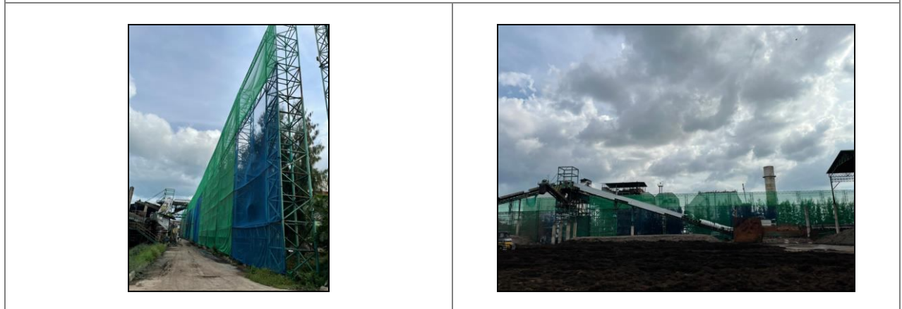
รูปที่ 11 ตาข่ายรอบโครงอาคารคลุมขานอ้อย บริเวณส่วนต่อจากเตาหม้อไอน้ำ
