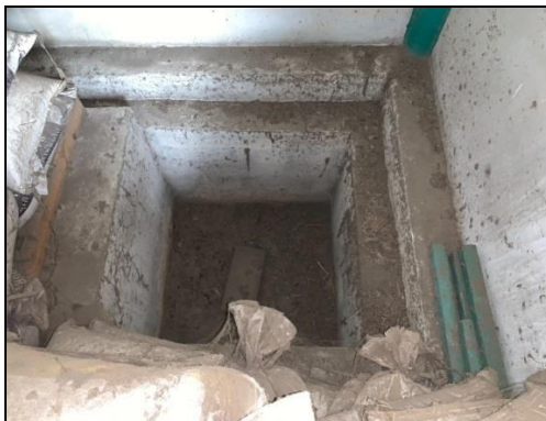
รูปที่ 64 พื้นที่รองรับสารเคมีในกรณีที่เกิดการรั่วไหลขึ้น
