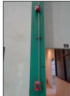
รูปที่ 49 ระบบแจ้งสัญญาณเตือนอัคคีภัย (Fire alarm system)
