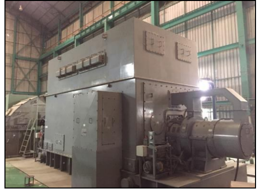
รูปที่ 29 การปิดครอบเครื่องจักรที่มีเสียงดัง
