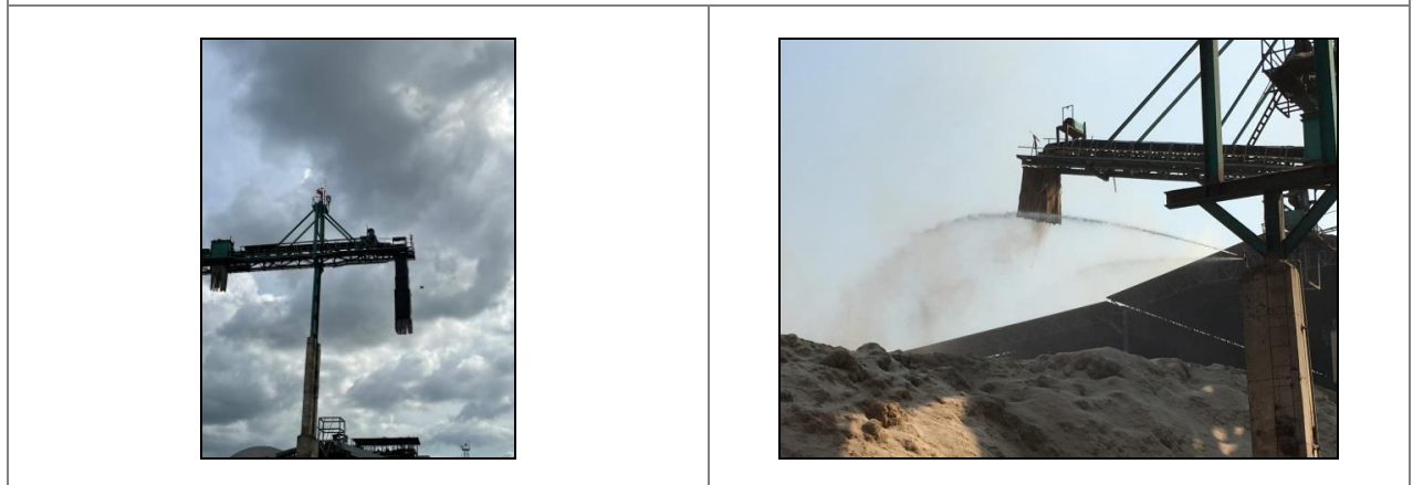
รูปที่ 9 อุปกรณ์ครอบป้องกันฝุ่นบริเวณลานกองเก็บขานอ้อย และระบบฉีดพ่นน้ำล้างบนขานอ้อย
