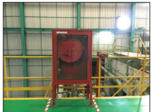
รูปที่ 51 ระบบท่อน้ำ หัวจ่ายน้ำดับเพลิง และระบบสายฉีดน้ำดับเพลิง
