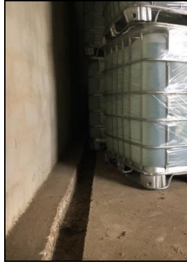
รูปที่ 60 รางระบายน้ำรอบอาคารเก็บสารเคมี
