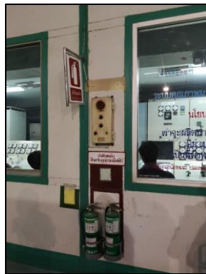
รูปที่ 49 ระบบแจ้งสัญญาณเตือนอัคคีภัย (Fire alarm system)
