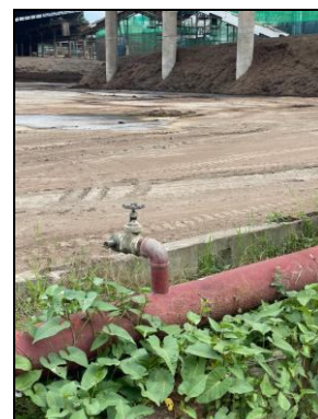
รูปที่ 8 ระบบหัวจ่ายน้ำดับเพลิงรอบบริเวณกองขานอ้อย
