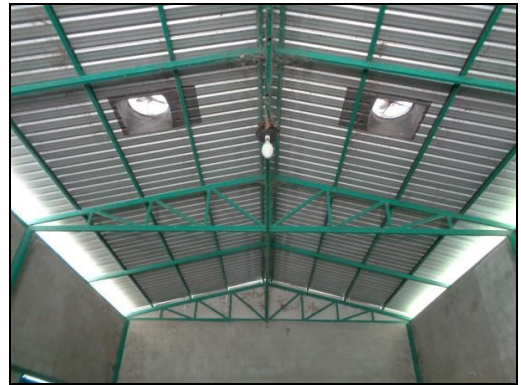
รูปที่ 63 ระบบระบายอากาศอาคารเก็บสารเคมี
