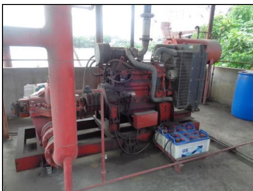
รูปที่ 52 เครื่องสูบน้ำดับเพลิง (Fire pump)
