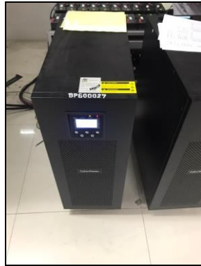
รูปที่ 68 Back Up และ UPS สำรอง
