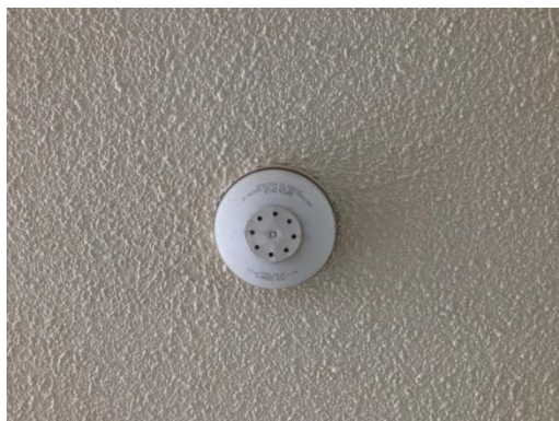
รูปที่ 2-24 เครื่องตรวจจับควัน/ความร้อน
