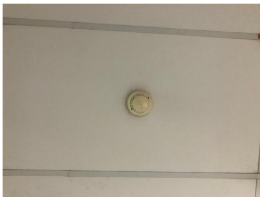
รูปที่ 2-24 เครื่องตรวจจับควัน/ความร้อน
