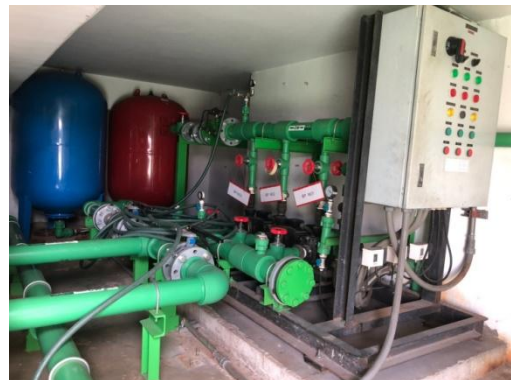
รูปที่ 2-47 ปั๊มน้ำใช้/ปั๊มน้ำดับเพลิง ชั้นตาดฟ้า
