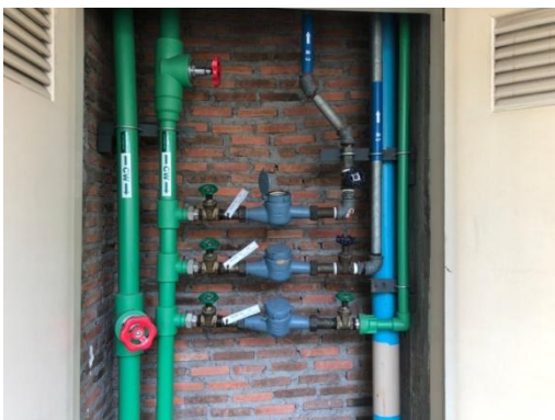
รูปที่ 2-35 มิเตอร์น้ำ
