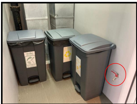
รูปที่ 2-28 ห้องพักขยะมีก๊อกน้ำและท่อระบายน้ำสำหรับทางน้ำไหล
