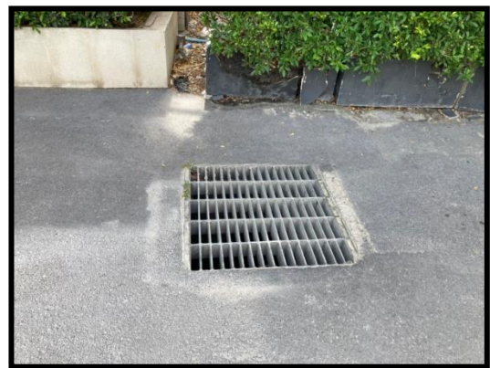
รูปที่ 2-16 ติดตั้งตะแกรงดักขยะบ่อพักน้ำสาธารณะ
