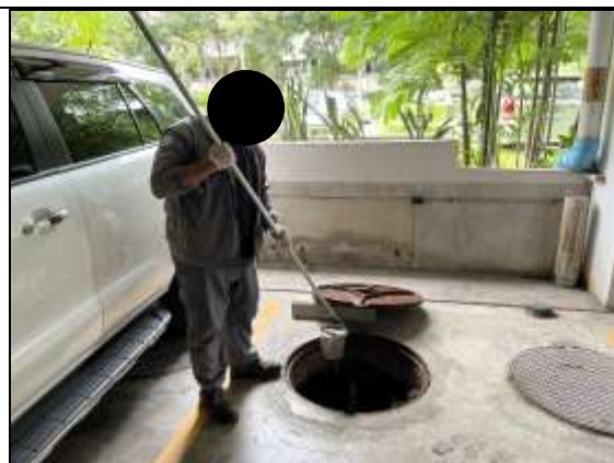
บ่อดักขยะก่อนออกสู่ท่อระบายน้ำสาธารณะ
