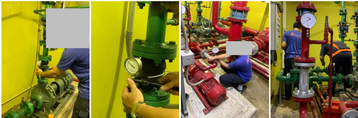
รูปที่ 2-50 การตรวจสอบท่อระบบส่งน้ำ
