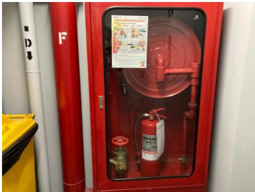
รูปที่ 2-24 ตู้อุปกรณ์ดับเพลิง
