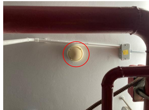
รูปที่ 2-20 เครื่องดับจับควัน
