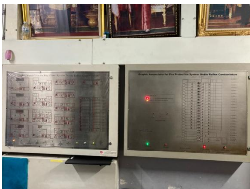
รูปที่ 2-37 แผงควบคุม (Fire Alarm Control Panel)
