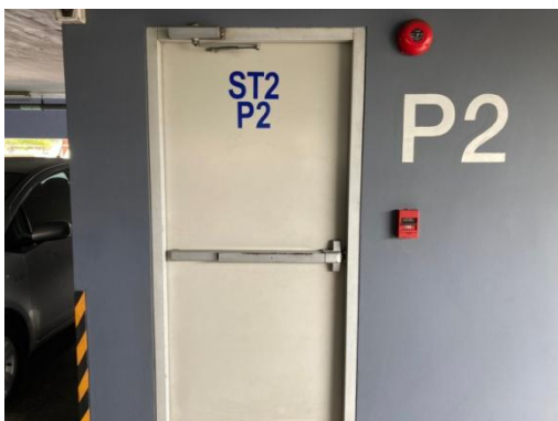
รูปที่ 2-21 เครื่องแจ้งเหตุโดยใช้มือดึง และกริ่งสัญญาณเตือนภัย
