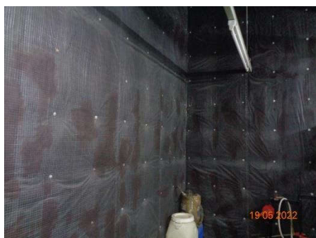
ภาพที่ 2.2-19 วัสดุกันเสียง ห้องเครื่องกำเนิดไฟฟ้า
