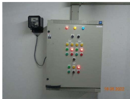
ภาพที่ 2.2-9 ระบบมิเตอร์ไฟฟ้าแยกสำหรับระบบบำบัดน้ำเสีย
