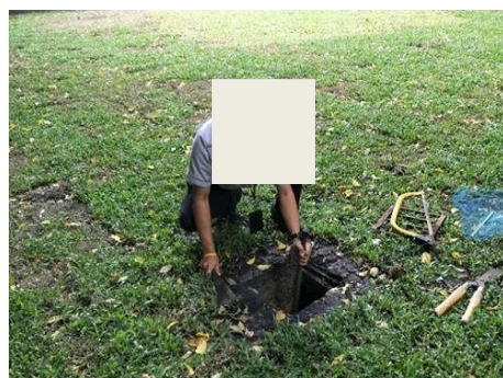
ภาพที่ 2.2-14 การตรวจสอบดูแลบ่อกักของระบบระบายน้ำ
