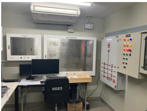
รูปที่ 2-28 แผงควบคุม (Fire Alarm Control Panel : FCP)
