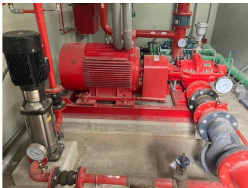
รูปที่ 2-31 ปั๊มน้ำดับเพลิง
