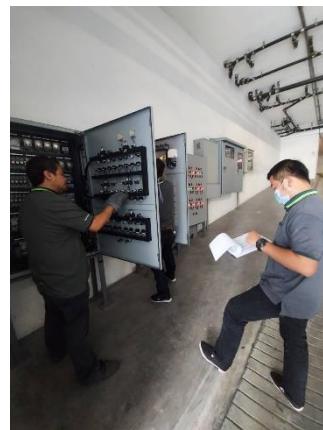
การตรวจสอบตู้ควบคุมระบบปั้มน้ำประจำวัน
