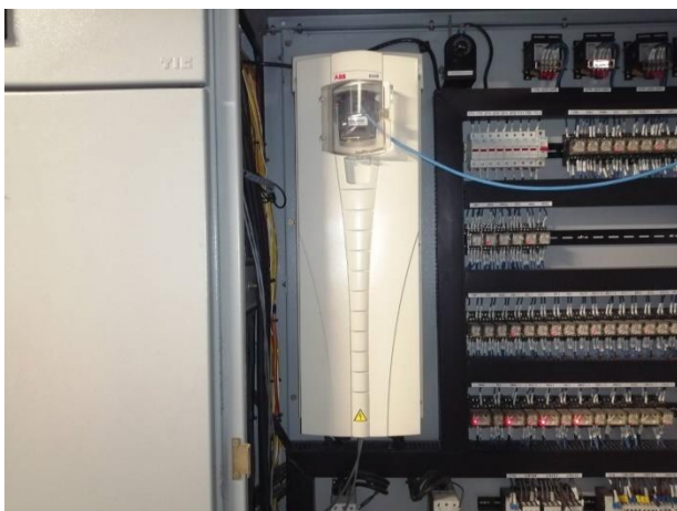
ติดตั้ง VSD เครื่องสูบน้ำเพื่อลดการใช้พลังงานไฟฟ้า
