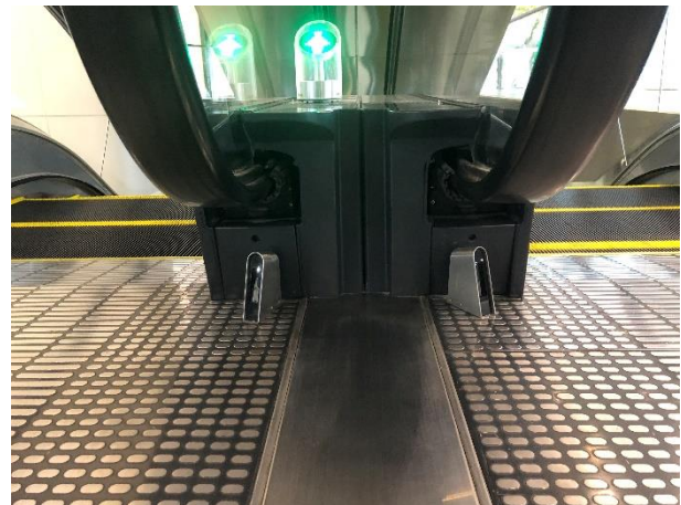
ระบบ Sensor บันไดเลื่อน
