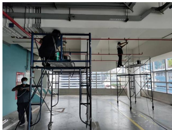
เปลี่ยนใช้หลอดไฟ ชนิด LED และการตรวจสอบหลอดไฟที่ไม่ได้ใช้งาน
