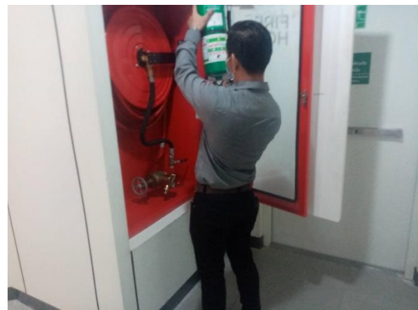
การตรวจสอบอุปกรณ์ดับเพลิงขั้นต้น รายเดือน
