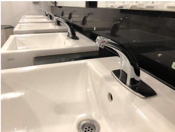
ติดตั้งก๊อกน้ำระบบ Sensor
