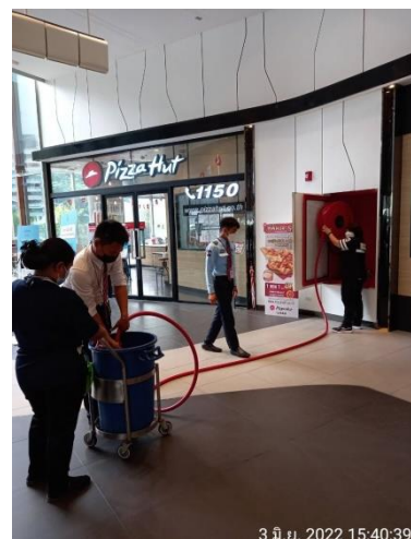
การตรวจสอบสายดับเพลิงเป็นประจำ
