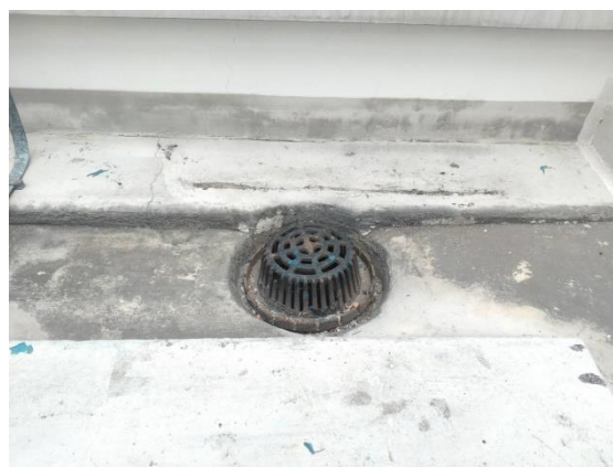
ใช้ตะแกรงครอบท่อและตรวจสอบท่อระบายน้ำประจำวัน
