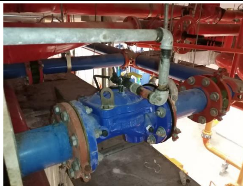
ระบบ โฟลทวาล์ว (Float Valve)
