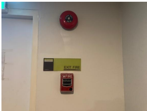
รูปที่ 2-31 สัญญาณแจ้งเตือนแบบกริ่งและอุปกรณ์แจ้งเตือน เหตุแบบมือดึง
