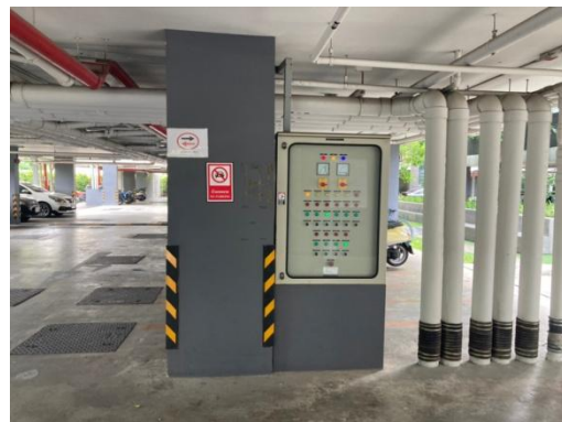
รูปที่ 2-43 ตู้บำบัดน้ำเสียของโครงการ
