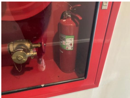
รูปที่ 2-27 ถังดับเพลิงชนิดมือถือ
