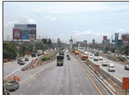
การติดตั้งป้ายเตือนพื้นที่ก่อสร้าง กม.20+600 (ขวาทาง)
