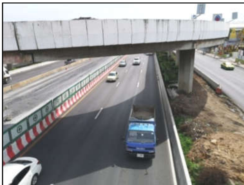
การติดตั้งกำแพงคอนกรีตกันพื้นที่ก่อสร้าง กม.14+000 (ขวาทาง)
