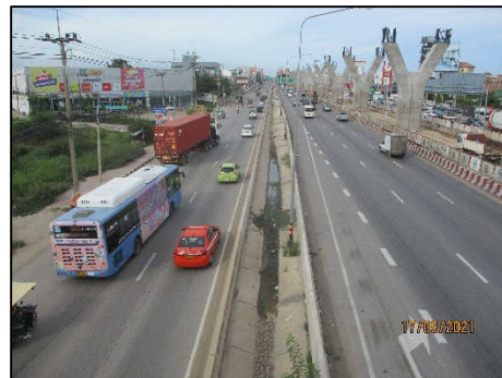
รางระบายน้ำที่เกาะแบ่งช่องทางหลักกับทางขนาน (SEPARATOR) กม.15+600 (ขวาทาง)
