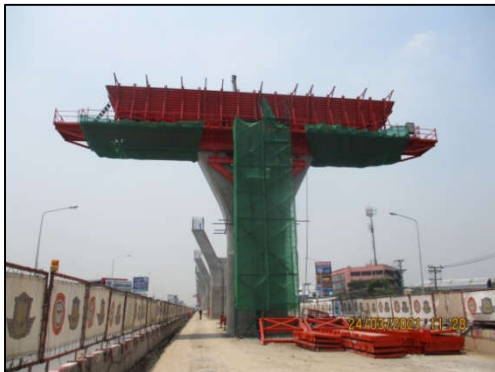
การติดตั้งตาข่ายชิงด้านล่างโครงสร้างทางยกระดับ กม.14+595
