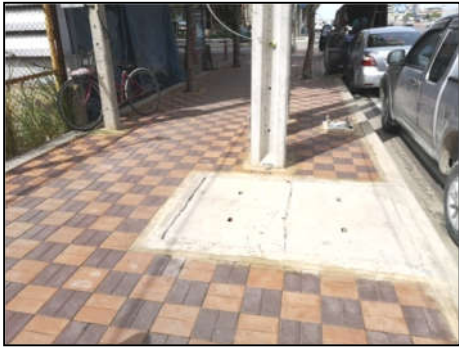
ท่อระบายน้ำบนทางเท้าที่ก่อสร้างแล้วเสร็จ กม.10+800 (ซ้ายทาง)
