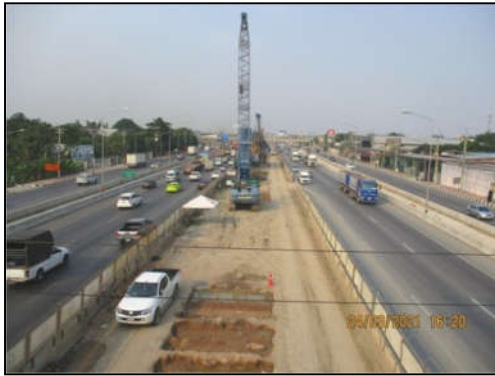
การติดตั้งกำแพงคอนกรีตกันพื้นที่ก่อสร้าง กม.13+315
