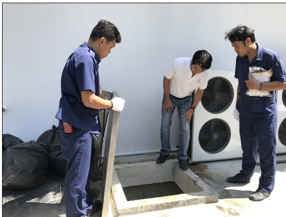
ภาพที่ 2-4 บ่อดักไขมัน และเจ้าหน้าที่แผนกซ่อมบำรุงประจำโครงการ
