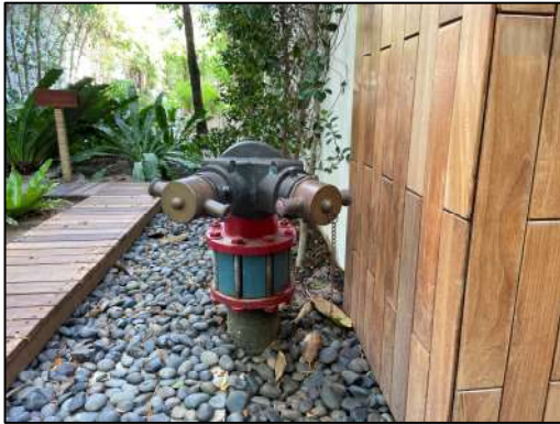
ภาพที่ 2-7 หัวรับน้ำดับเพลิง และถังดับเพลิง
