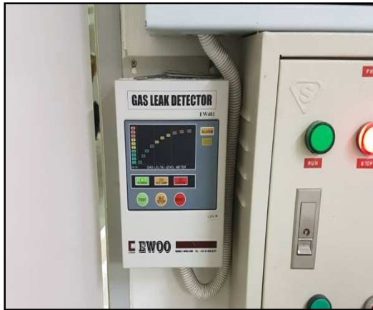
ภาพที่ 2-12 เครื่องส่งสัญญาณเสียงเมื่อก๊าซรั่ว
