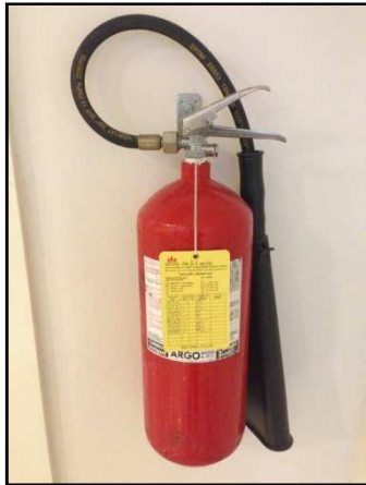
ภาพที่ 1-20 ถังดับเพลิงแบบมือถือ
