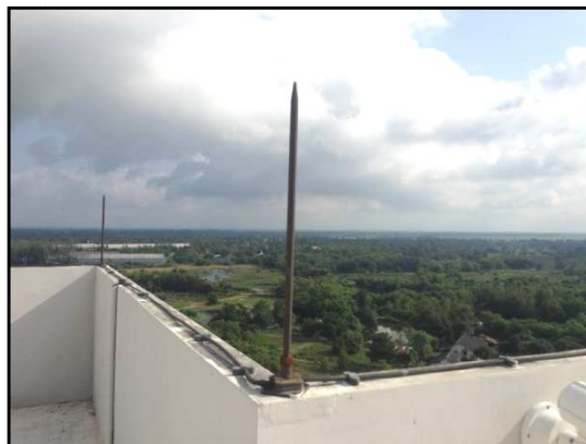
ภาพที่ 1-13 เสาหล่อฟ้า
