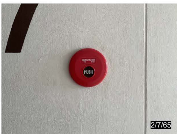
ภาพที่ 2-21 ชุดกดแจ้งเหตุแบบใช้มือ (Manual Station)
