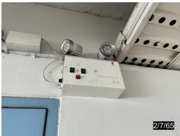
ภาพที่ 2-23 ไฟส่องสว่างฉุกเฉิน
