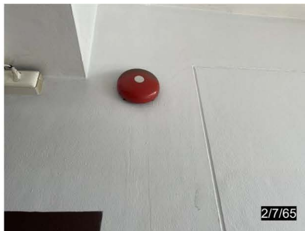
ภาพที่ 2-20 อุปกรณ์ส่งสัญญาณเพื่อให้หนีไฟ (Fire Alarm Bell)
