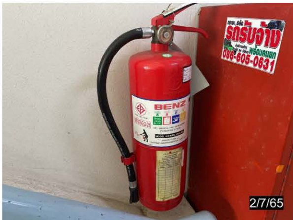
ภาพที่ 2-22 เครื่องดับเพลิงแบบมือถือ)
