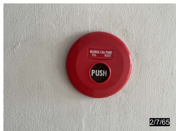
ภาพที่ 2-21 ชุดกดแจ้งเหตุแบบใช้มือ (Manual Station)
