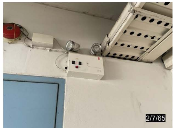
ภาพที่ 2-23 ไฟส่องสว่างฉุกเฉิน
