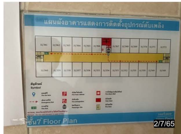
ภาพที่ 2-28 แผนผังตำแหน่งที่ติดตั้งอุปกรณ์ดับเพลิงต่างๆ
