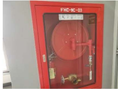
ภาพที่ 3-20 สายฉีดน้ำดับเพลิงและตู้เก็บสายฉีด (FHC) อยู่ในสภาพพร้อมใช้งาน
