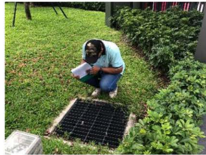
ภาพที่ 3-14 การตรวจสอบการสะสมของตะกอนดินใน บ่อพักและท่อระบายน้ำ
