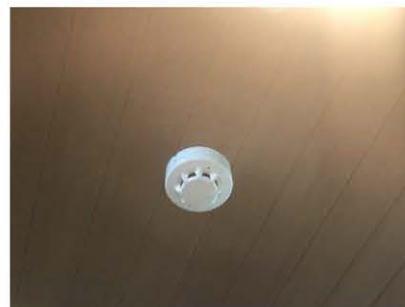
ภาพที่ 2-63 เครื่องตรวจจับควัน (Smoke Detector)
