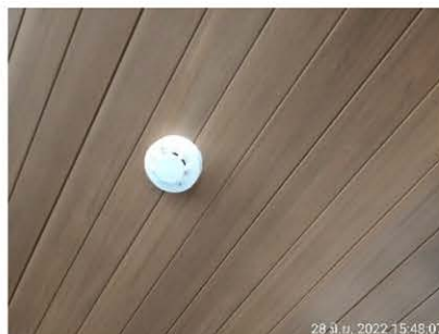
ภาพที่ 2-63 เครื่องตรวจจับควัน (Smoke Detector)
