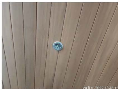
ภาพที่ 2-60 ระบบหัวกระจายน้ำดับเพลิงอัตโนมัติ (Sprinkler System)
