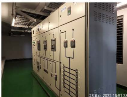
ภาพที่ 2-42 ระบบควบคุมไฟฟ้าภายใน โครงการ
