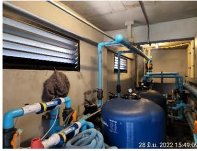
ภาพที่ 2-25 ระบบกรองน้ำของสระว่ายน้ำ ภาพที่ 2-26 การดูแลทำความสะอาด สระว่ายน้ำ
