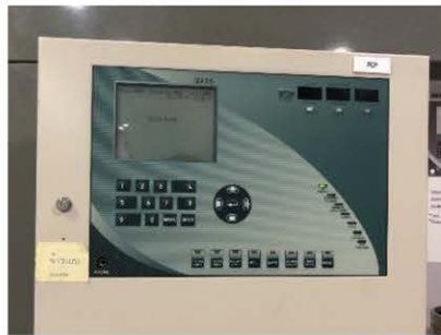
ภาพที่ 2-62 แผงควบคุม (Fire Alarm Control Panel)
