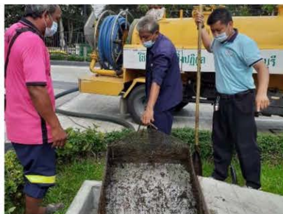
ภาพที่ 2-82 การสูบน้ำสิ่งปฏิกูลและจัดเก็บกากไขมันจากระบบบำบัดน้ำเสียไปกำจัด
