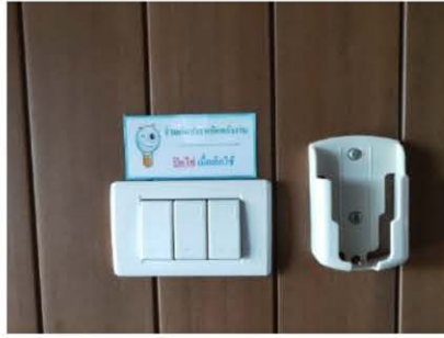
ภาพที่ 2-46 สวิตช์ควบคุมอุปกรณ์ไฟฟ้าแสงสว่างแบบแยกส่วน
