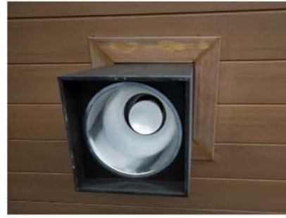
ภาพที่ 2-47 ใช้บัลลาสต์อิเล็กทรอนิกส์ แทนบัลลาสต์ชนิดแกนเหล็กธรรมดา ภาพที่ 2-48 ติดตั้งหลอดไฟประหยัดพลังงาน Light Emitting Diode (LED)
