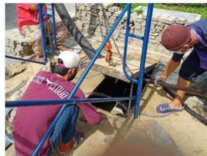
ภาพที่ 2-82 การสูบน้ำสิ่งปฏิกูลและจัดเก็บกากไขมันจากระบบบำบัดน้ำเสียไปกำจัด
