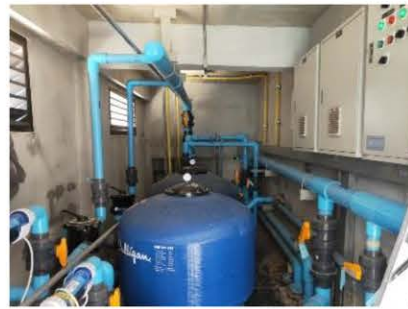
ภาพที่ 3-12 ระบบกรองน้ำสระว่ายน้ำอยู่ในสภาพดีไม่ ชำรุด
