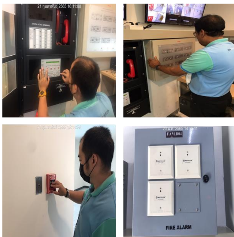
ภาพที่ 2-14 ภาพการบำรุงรักษาระบบแจ้งเตือนเหตุเพลิงไหม้
