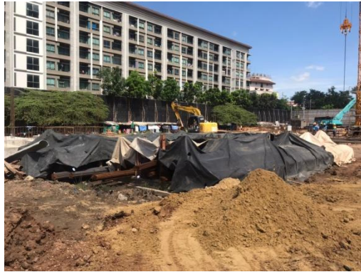
รูปที่ 2-4 กองวัสดุที่มีฝุ่นหรือเศษวัสดุที่เหลือใช้ต้อง ปิดหรือคลุมด้วยผ้าใบให้มิดชิด
