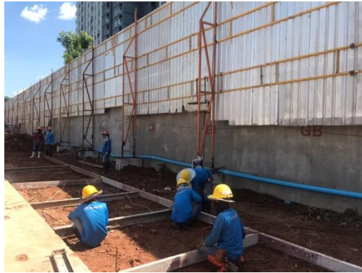
รูปที่ 2-13 ท่อระบายน้ำรอบโครงการ
