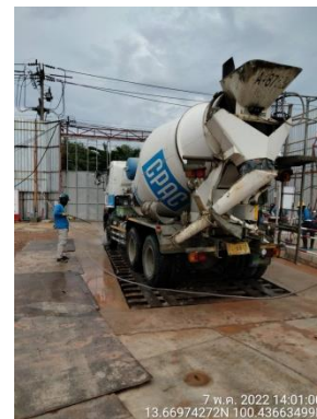
รูปที่ 2-6 ทำความสะอาดล้อรถบรรทุกโดยใช้น้ำฉีดก่อนออกจากโครงการทุกครั้ง
