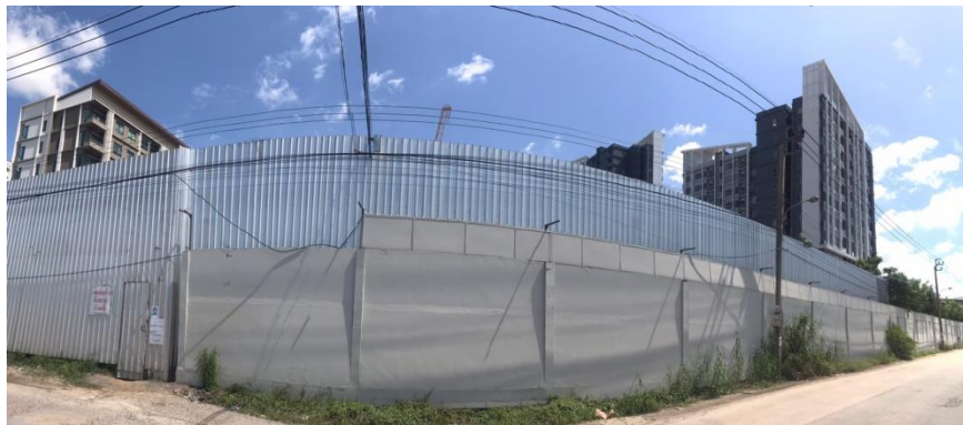
รูปที่ 2-1 รั้ว Metal sheet ความสูง 6 เมตร บริเวณแนวเขตที่ดิน
