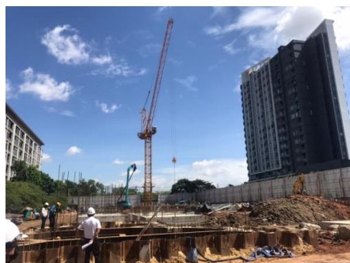
รูปที่ 2-45 เครนเป็นแบบพับแขนได้ แขนจะอยู่เฉพาะในพื้นที่ตึกตรงเท่านั้น
