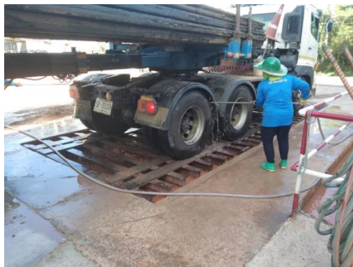
รูปที่ 2-6 ทำความสะอาดล้อรถบรรทุกโดยใช้น้ำฉีดก่อนออกจากโครงการทุกครั้ง
