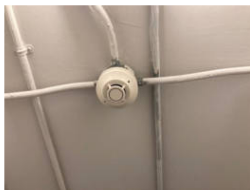
รูปที่ 2-12 ห้องหม้อแปลงไฟฟ้า ติดตั้งเครื่องตรวจจับควัน และความร้อน ติดป้ายแสดงอันตรายไฟฟ้าแรงสูง
