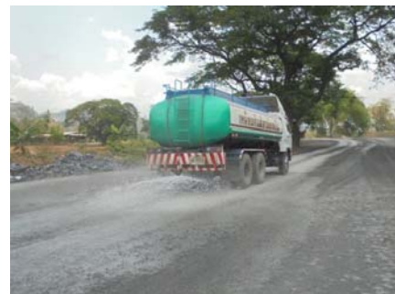
รูปที่ 2-20: การฉีดพรมน้ำบริเวณเส้นทาง ขนส่งแร่
