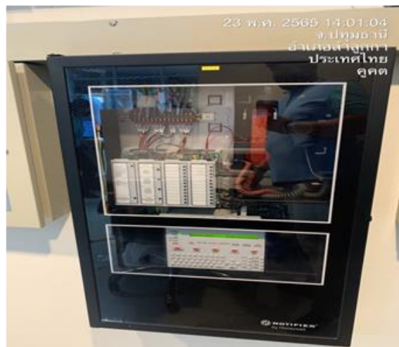
ภาพที่ 2-14 ภาพการบำรุงรักษาระบบแจ้งเตือนเหตุเพลิงไหม้
