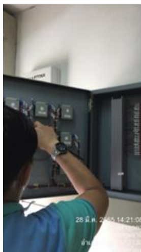
ภาพที่ 2-14 ภาพการบำรุงรักษาระบบแจ้งเตือนเหตุเพลิงไหม้
