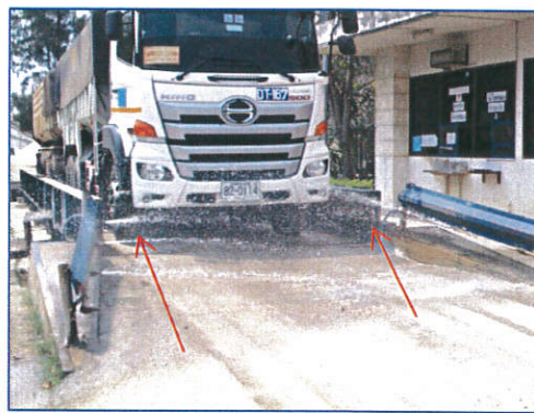
(8) ระบบสเปรย์น้ำล้างล้อของโครงการ
