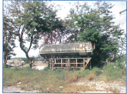
(12) ถังสำรองน้ำสำหรับระบบสเปรย์น้ำ
