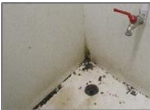
รูปที่ 2-15 ท่อรวบรวมน้ำเสียจากห้องพักมูลฝอยรวม
