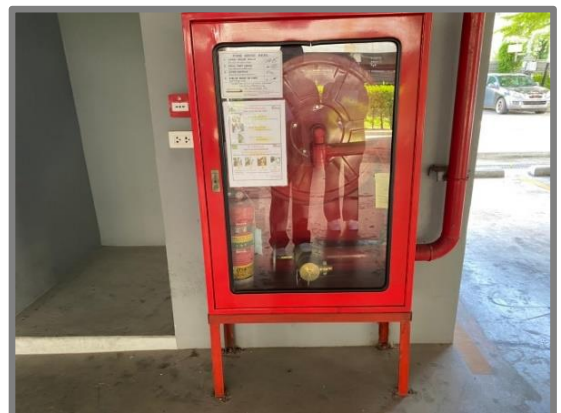
รูปที่ 2-24 ระบบปั้มน้ำดับเพลิงและตู้ฉีดน้ำดับเพลิง
