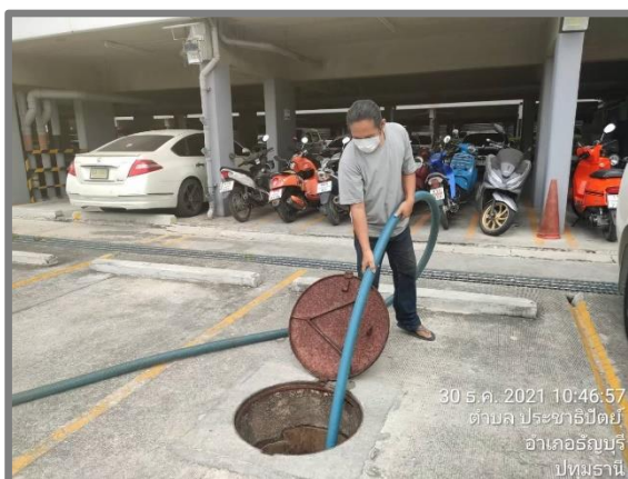
รูปที่ 2-41 การสูบละกอน
