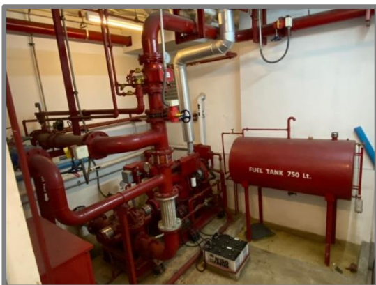
รูปที่ 2-24 ระบบปั้มน้ำดับเพลิงและตู้ฉีดน้ำดับเพลิง
