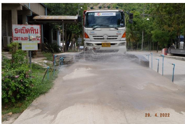
ภาพที่ 2-10 ระบบล้างล้อรถบรรทุกก่อนออกจากพื้นที่โครงการ
