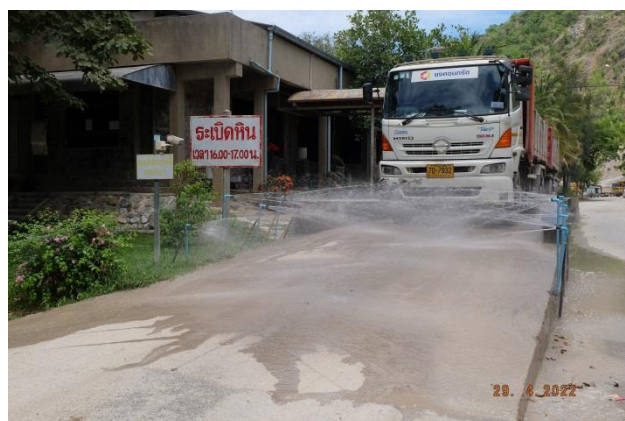
ภาพที่ 2-10 ระบบล้างล้อรถบรรทุกก่อนออกจากพื้นที่โครงการ
