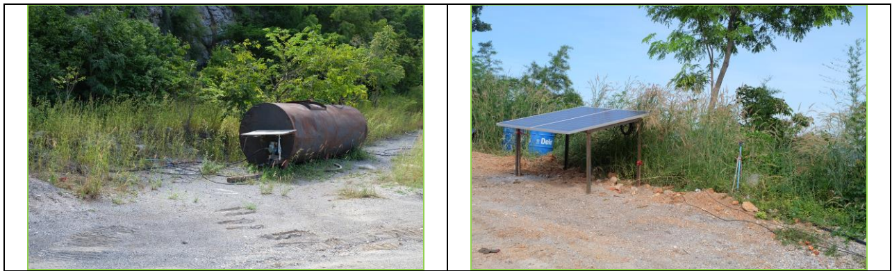
รูปที่ 4 เติมน้ำระบบท่อน้ำหยดโดยใช้แผงโซลาร์เซลล์เพื่อฉีดรดต้นไม้บริเวณขอบเหมือง
