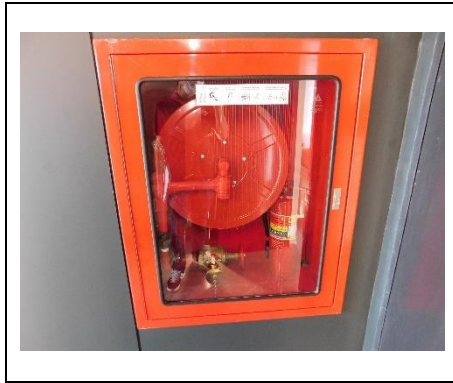
รูปที่ 2.3-23 ตู้สายฉีดน้ำดับเพลิง
