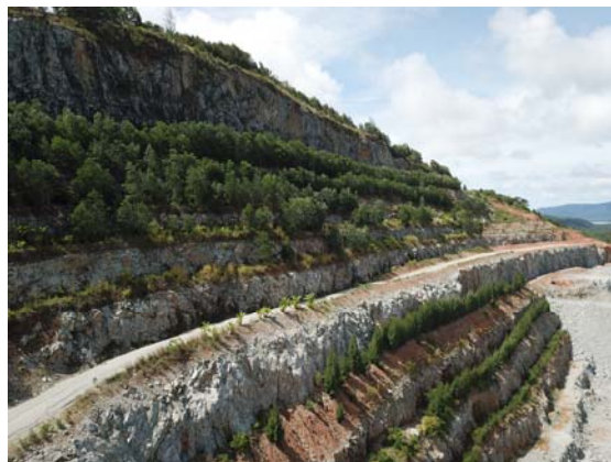
(11) การฟื้นฟูชั้นบันไดหน้าเหมืองที่ไม่ใช่ประโยชน์เพื่อการทำเหมืองแล้ว
