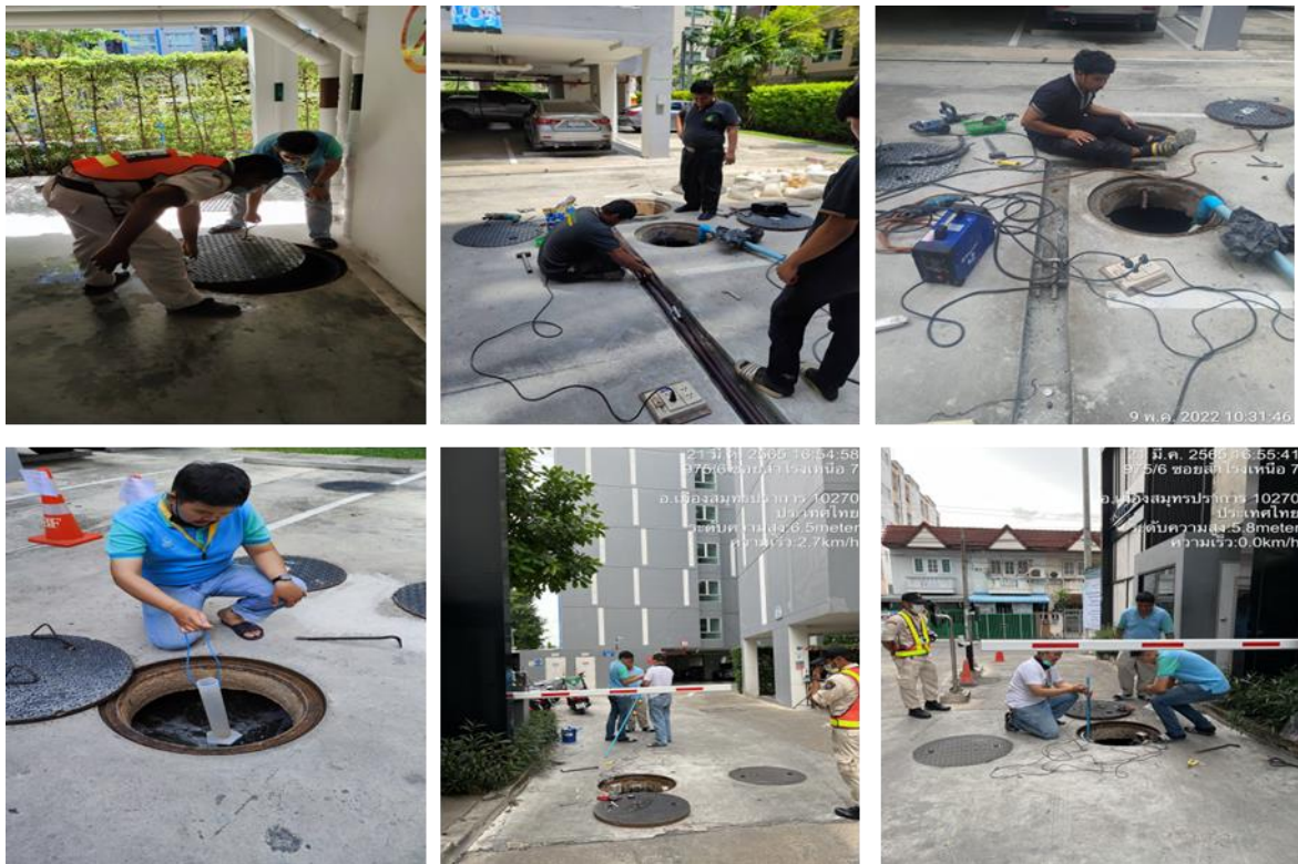
ภาพที่ 2-12 ภาพการดูแลตรวจสอบระบบบำบัดน้ำเสีย และระบบระบายน้ำของโครงการ
