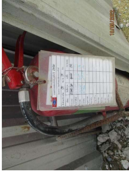
รูปที่ 3-45 ป้ายบันทึกการตรวจสอบถังดับเพลิง
