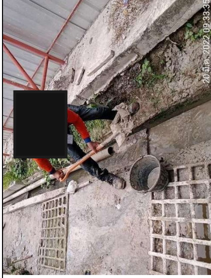
รูปที่ 3-41 การตรวจสอบวางระบายน้ำและการลอกวางระบายน้ำ
